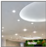
parfait pour les installations d'éclairage
